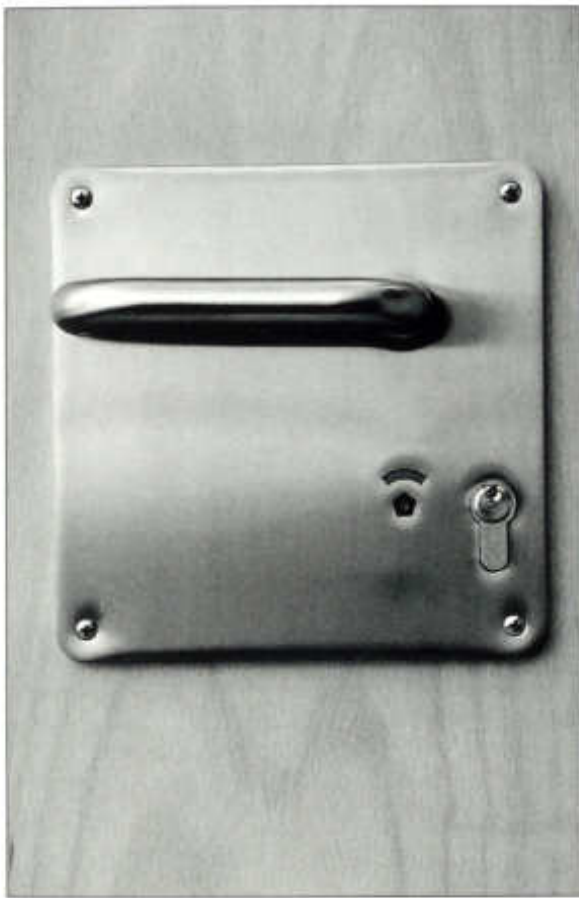
Schloß-Beschlag-Kombination für behindertengerechte WC-Türen
